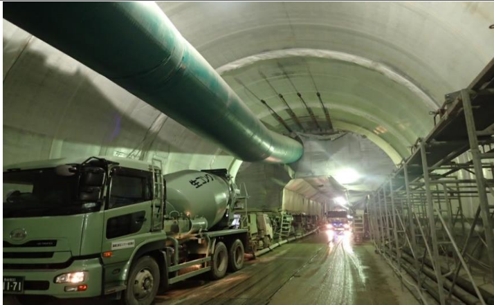
新長崎トンネル(東)工区 (H30年9月竣工予定)【長崎市】
