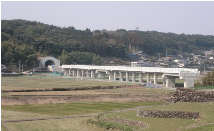
第1本明トンネル外1箇所他工区【諫早市】 (H29年11月竣工予定)
