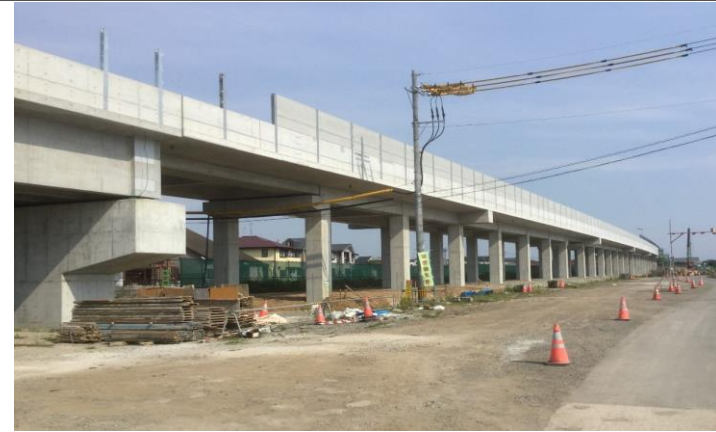
竹松高架橋工区 (H29年8月竣工予定)【大村市】
