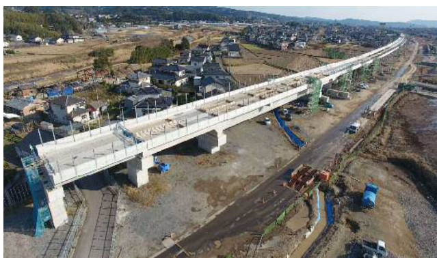
福重高架橋他工区（大村市内）
