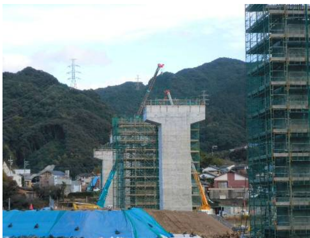
経ヶ岳トンネル工区（長崎市内）
