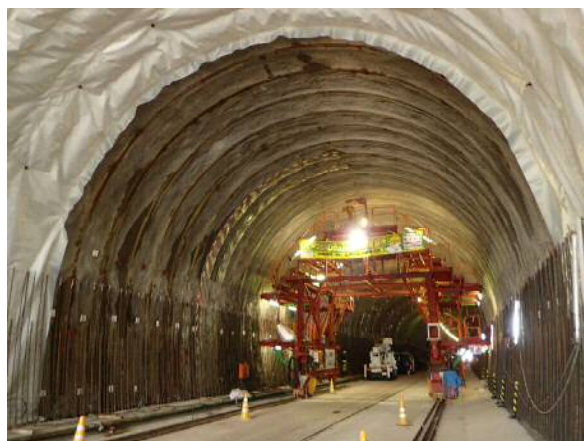
第1本明トンネル工区（諫早市内）
